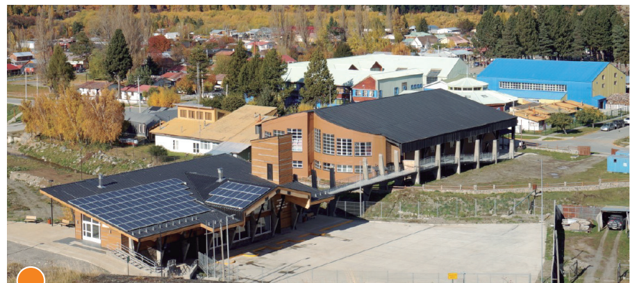
28 kWp Photovoltaik-Anlage auf dem Busterminal in Cochrane, Región de Aysén
